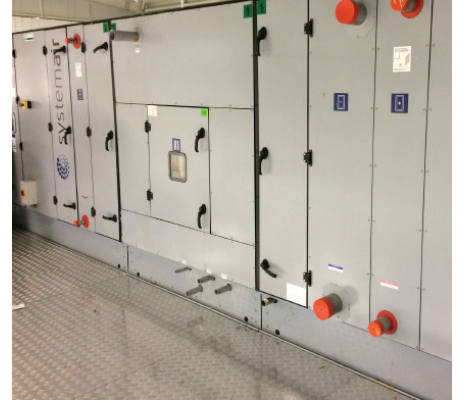
Kabin üzerine yerleştirilmiş unite AMU Unit placed on top of the booth
